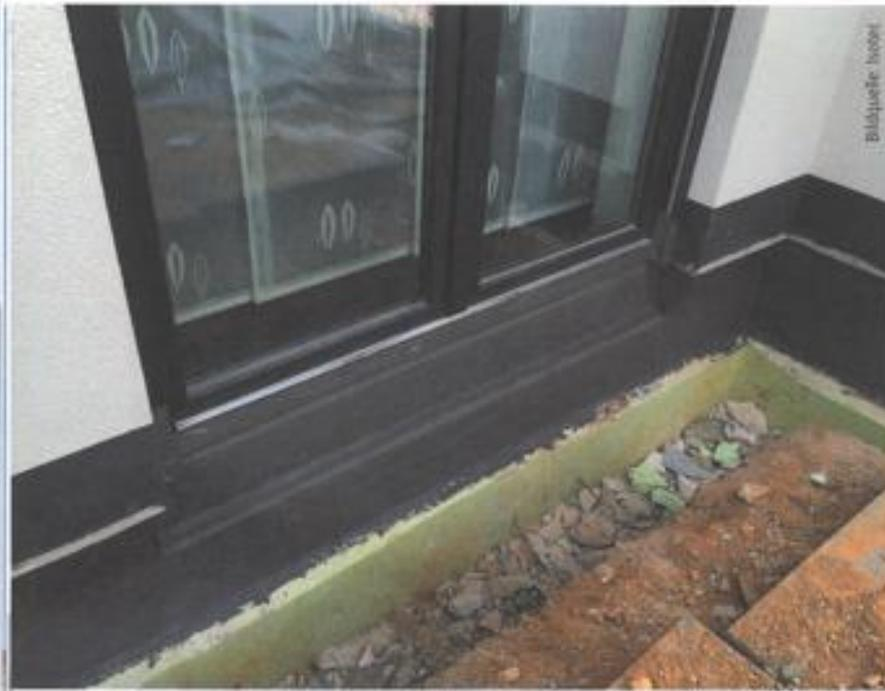
Abb. 6: Unter Einbeziehung von Systemkomponenten wie Dichtbändern und der fachgerechten Ausführung können mit flexiblen polymermodifizierten Dickbeschichtungen auch diese kritischen Bereiche zuverlässig abgedichtet werden.
